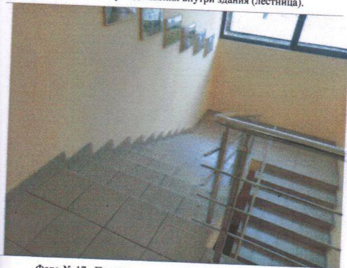
Фото № 17 – Пути движения внутри здания (лестница).
