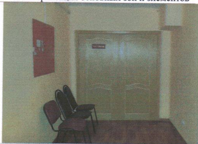
Фото № 20 – Пути движения внутри здания (двери).
