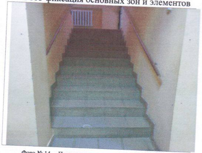
Фото № 14 – Пути движения внутри здания (лестница).
