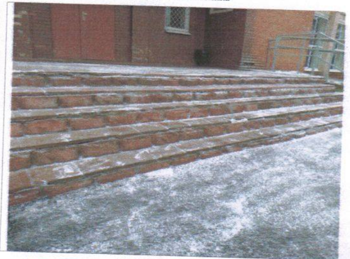
Фото № 4 –Наружная лестница.
