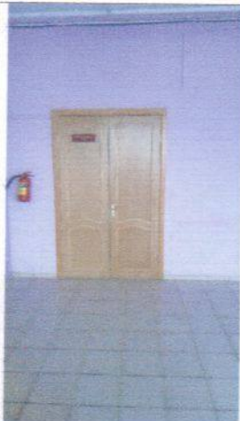
Фото №21 – Пути движения внутри здания (двери).
