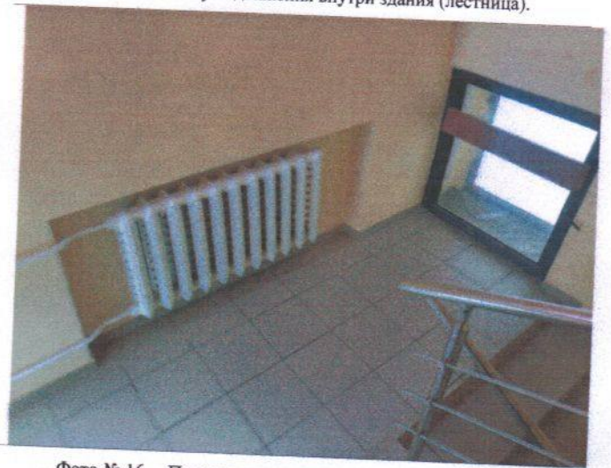
Фото № 16 – Пути движения внутри здания (лестница).
