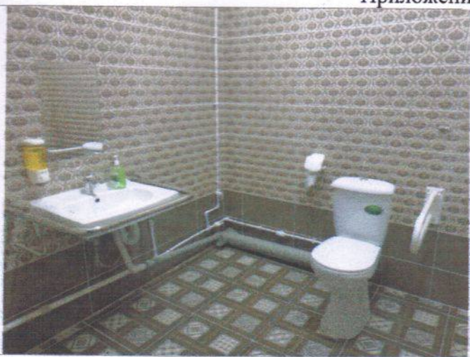
Фото № 25 – Санитарно-гигиеническое помещение
