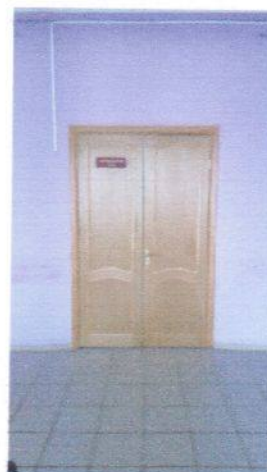
Фото №22 – Пути движения внутри здания (двери).
