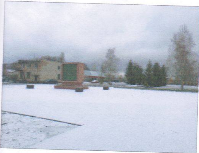
Фото № 1 –Подходы к объекту
