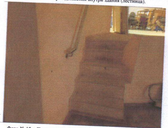
Фото № 18 - Пути движения внутри здания (лестница на сцену)
