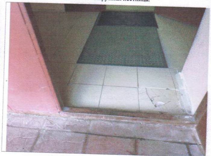
Фото № 6 – Входная дверь (внешняя).
